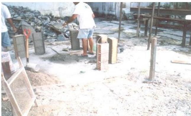
Figura 3.17 – Canteiro da fabricação dos prismas
