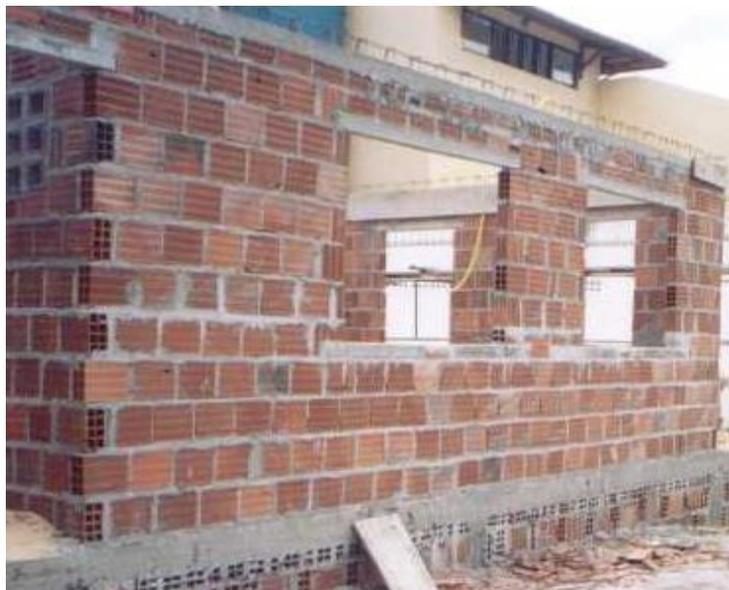
Figura 2.13 (b) – Alvenaria de vedação com função estrutural
