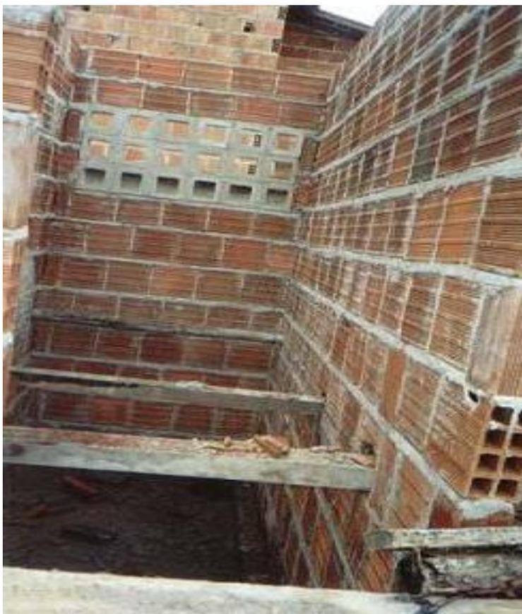
Figura 2.13 (a) - Alvenaria de elevação com função estrutural similar à dos edifícios tipo “caixão”
