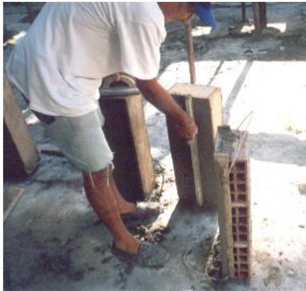
Figura 3.16 – Sarrafeamento do revestimento
